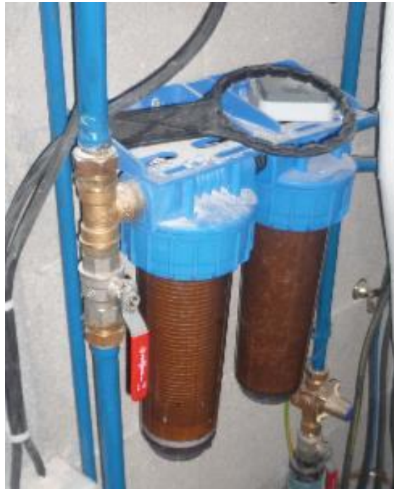
L'entretien de l'installation (cuves, filtres et pompe)
