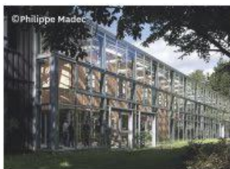
Conservatoire botanique / Brest (29) / 2020 / Philippe Madec (MOe) / Enveloppe caissons paille
