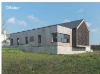
Restaurant scolaire / La Grignonais (44) / 2021 / Faber (MOe) / Ossature bois isolée en paille
