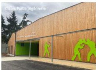
Dojo / Château-Gontier-sur-Mayenne (53) / 2023 / Architecte Fardin (MOe) / Façades bois isolées en paille
