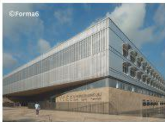
Lycée / St Philbert-de-Grand-Lieu (44) / En cours / Forma6 (MOe) / Façades bois isolées en paille/charvre
