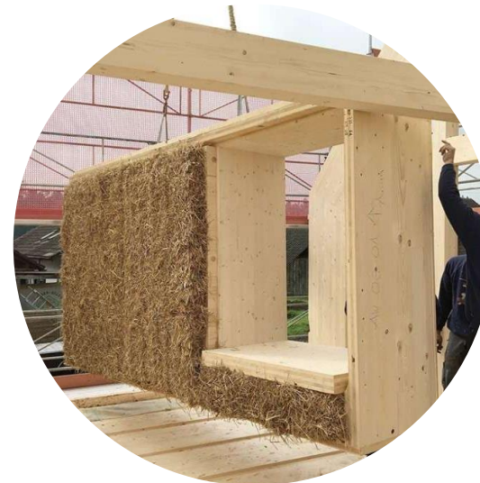
Bottes de paille pour la construction
