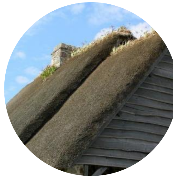
Toitures en chaume
